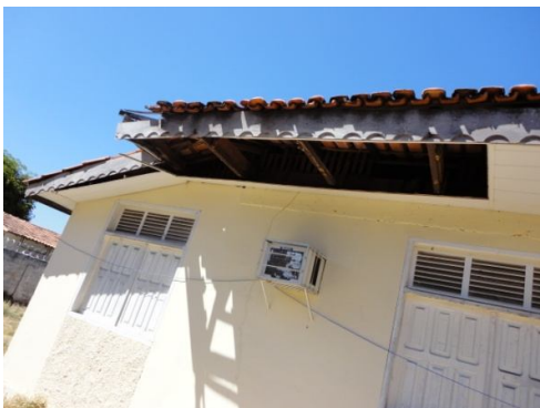
Foto 3 - Detalhe do Forro do Prédio do Juizado Especial
