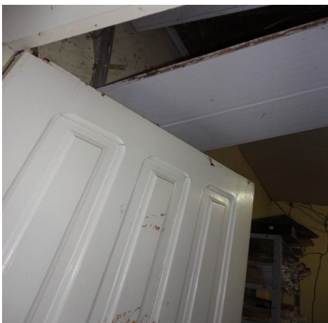
Foto 10 - Detalhe do forro da Sala de Arquivo
