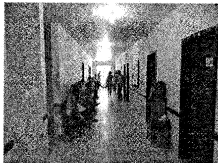
Foto 04 – Acesso às demais dependências
