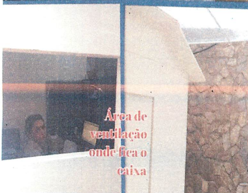
Área de ventilação com acesso ao atendimento
