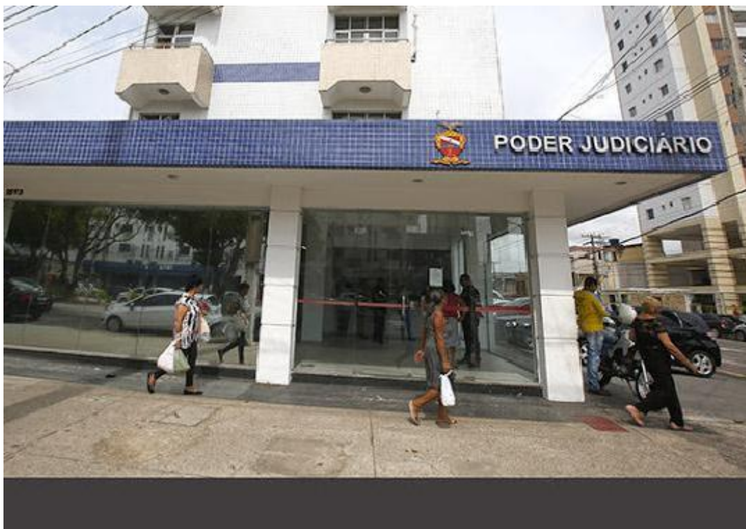
Central de Atermação e Distribuição faz atendimento remoto
