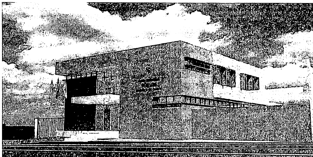
Ilustração 1 – Imagem da fachada lateral direita
