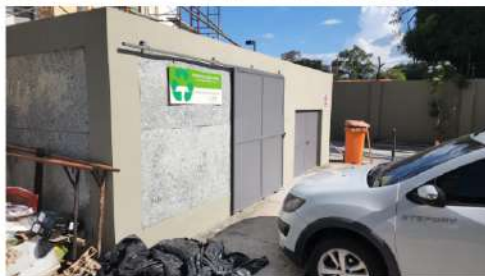
Figura 4 – Foto do local de instalação.
