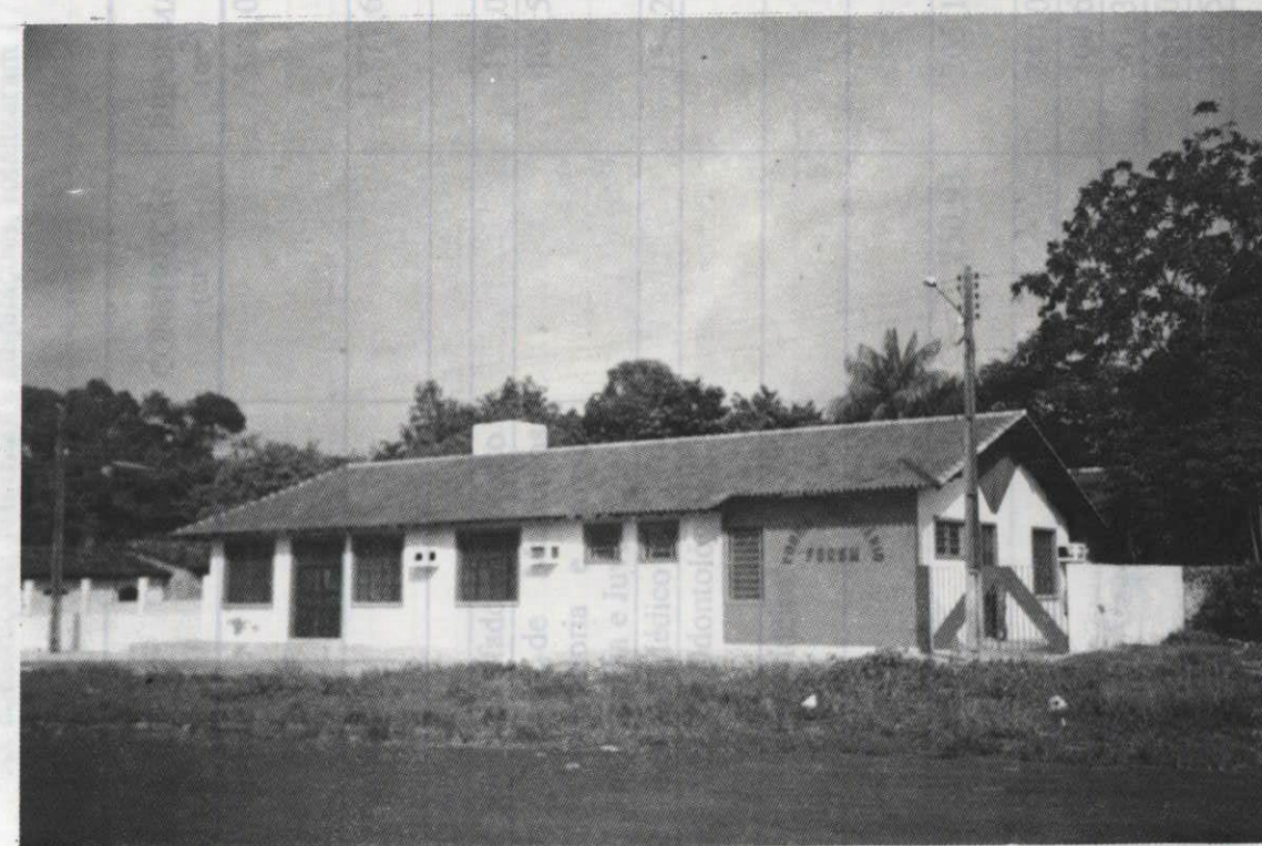
Reforma e Ampliação do Forum de Benevides
