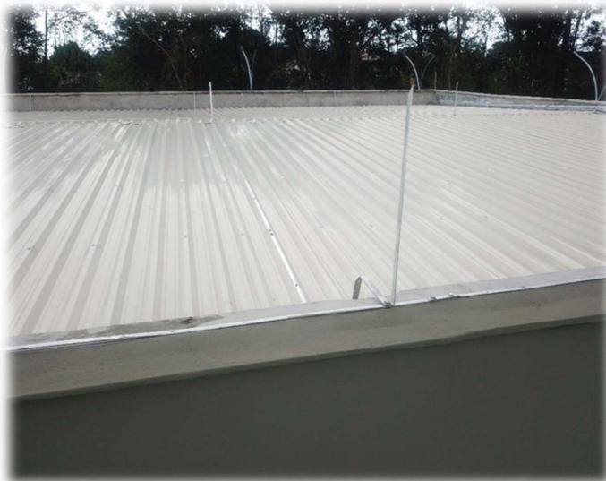
Figura 14 – SPDA no telhado
