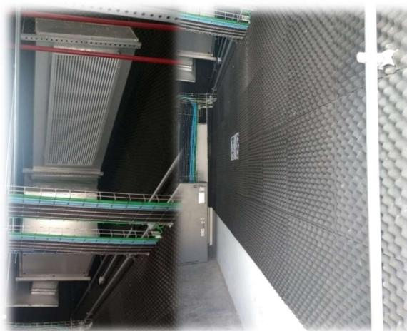
Figura 15 – Detalhe de exaustor no teto e revestimento antiruído em sala de gerador
