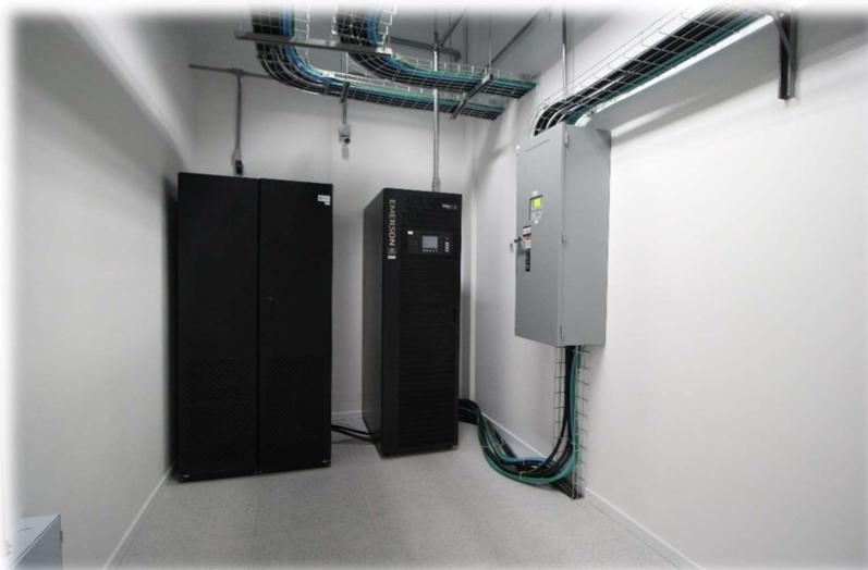
Figura 16 – Componentes UPS (Módulo de controle e banco de baterias)
