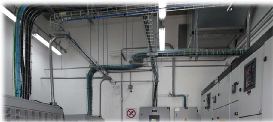
Figura 11 – Detalhes da infraestrutura de encaminhamento e proteção de cabos elétricos
