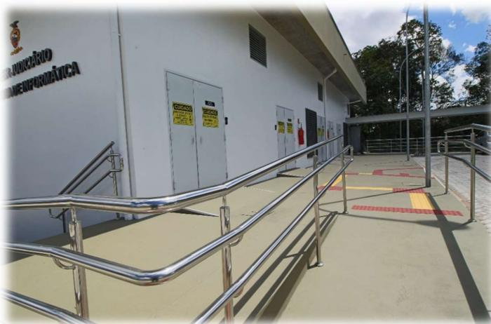
Figura 06 – Detalhe dos guarda corpos das rampas
