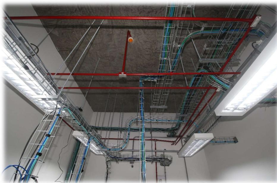
Figura 18.b – Luminárias e leitos aramados no teto
