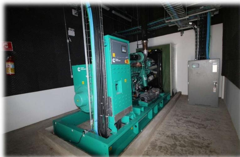
Figura 19 – Gerador a diesel com tanque de combustível na base
