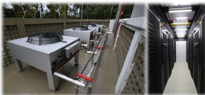
Figura 23 – Componentes do sistema de refrigeração de precisão da sala segura
