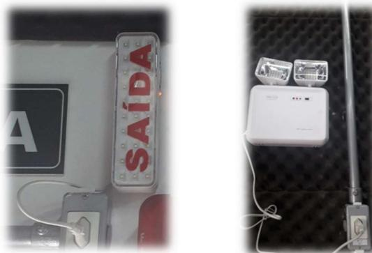
Figura 18.a – Modelos de luminárias de emergência
