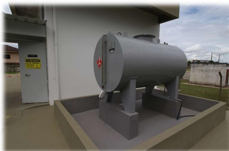
Figura 20 – Tanque de óleo diesel com capacidade de 3.000 litros
