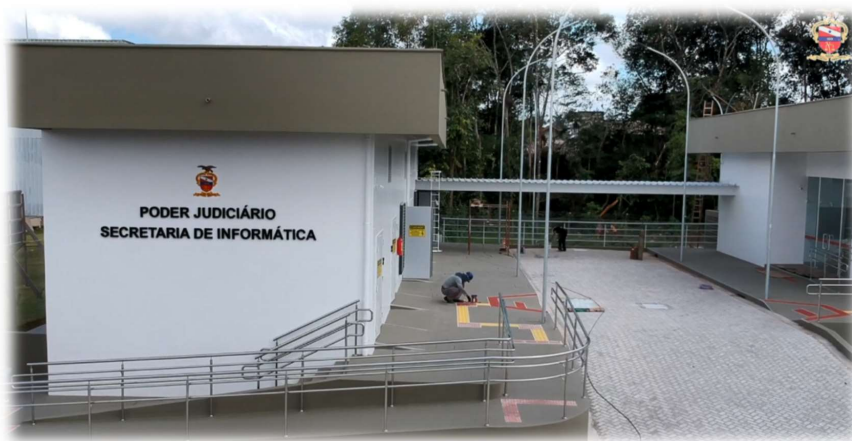
Figura 03 – Detalhe de paredes externas e platibandas
