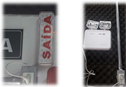
Figura 18.a – Modelos de luminárias de emergência
