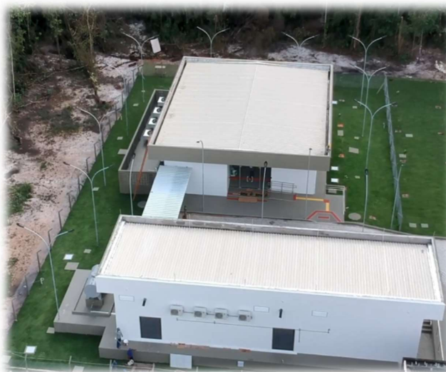
Figura 17 – Visão aérea do posteamento de iluminação
