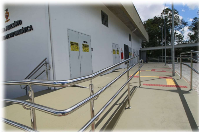
Figura 06 – Detalhe dos guarda corpos das rampas
