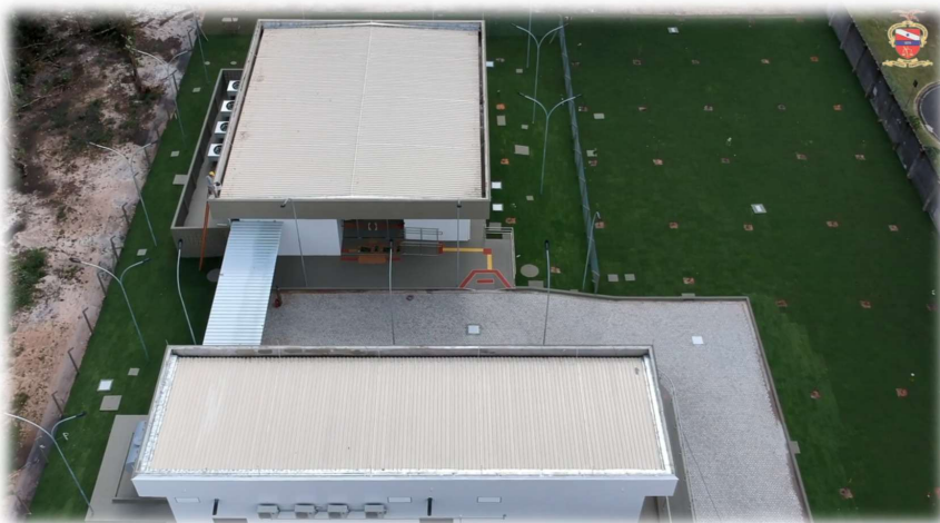
Figura 04 – Detalhe dos telhados
