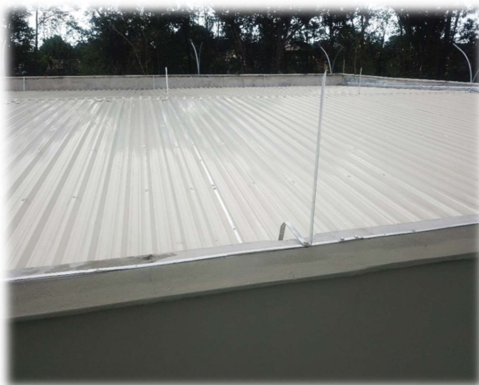
Figura 14 – SPDA no telhado
