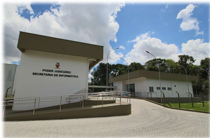
Figura 02 – Foto dos blocos que compõem o datacenter principal
